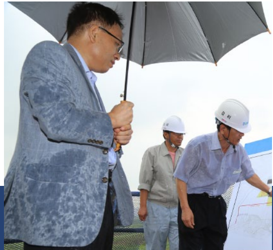
GFEZ 청장 하동지구 공사현장 방문 (2013.08.23)
