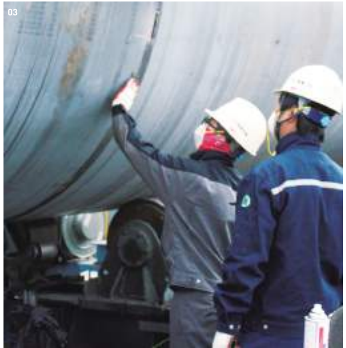
01 강관SAW용접 02 배관야적 03 용접부위 확인하는 기술자들
